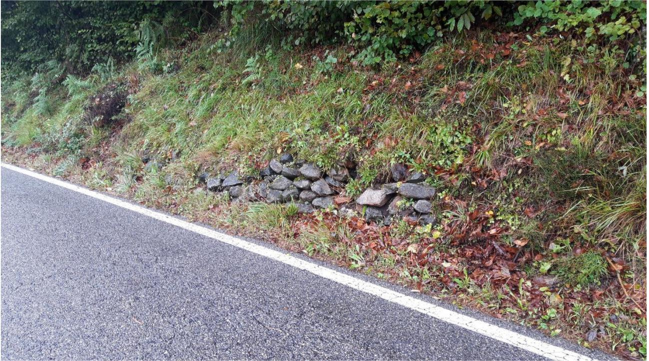
I muretti a secco lungo il tratto oggetto di intervento, eseguiti in passato come sistema di contenimento degli effetti erosivi del versante, evidenziano discontinuità e inefficienza funzionale, al punto da rappresentare essi stessi fonte di pericolo alla circolazione.
