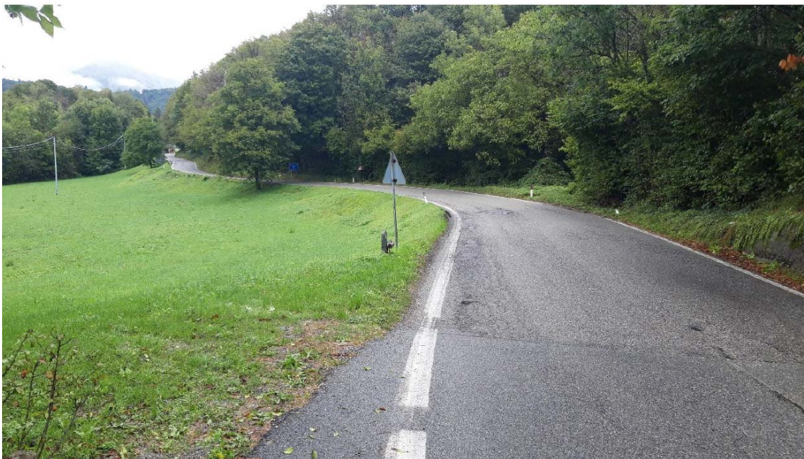
Foto 1 Vista del prato sul lato di valle della strada
